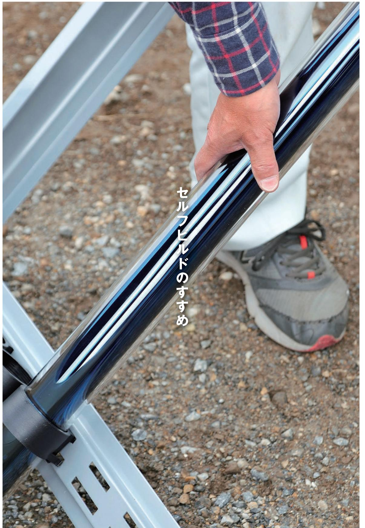
SOLA HEATERは、「真空管ヒートパイプ+貯水タンク+それを支える台座」というシンプルな構造。パーツ数も多くありません。200Lタイプでも、大人が2人いれば、初めての方でも組立が可能です。「自分で組み立てると愛着が湧く」と多くの方がセルフビルトで設置されています。但し、給湯器との配管は、安全性等を考えプロに任せることをお勧めします。
